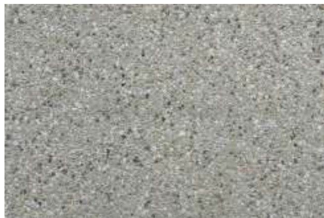
Figure 11 Béton désactivé clair pour les quais
